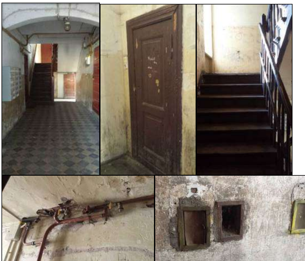
Fot. Części wspólne kamienic zlokalizowanych na terenie wskazanym do rewitalizacji
