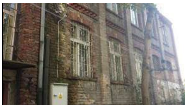
Fot. Budynek dawnej świetlicy środowiskowej przeznaczony pod planowany Sąsiedzki Dom Integracyjny
