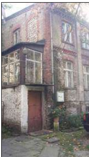
Fot. Budynek dawnej świetlicy środowiskowej przeznaczony pod planowany Sąsiedzki Dom Integracyjny
